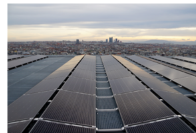
Verschattungselemente Nachträglich aufgebracht Transparente PV
