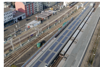
Nachträglich installierte PV-Anlagen
