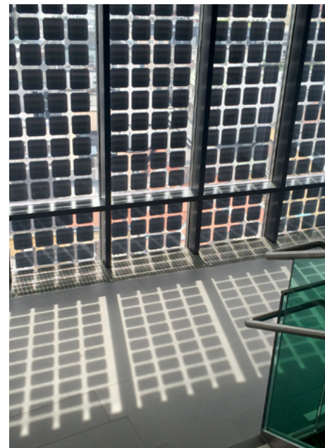
Gebäudeintegrierte PV Transparente PV Fassaden-PV
