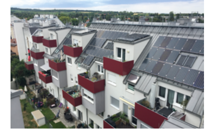
PV auf Mehrparteiengebäude
