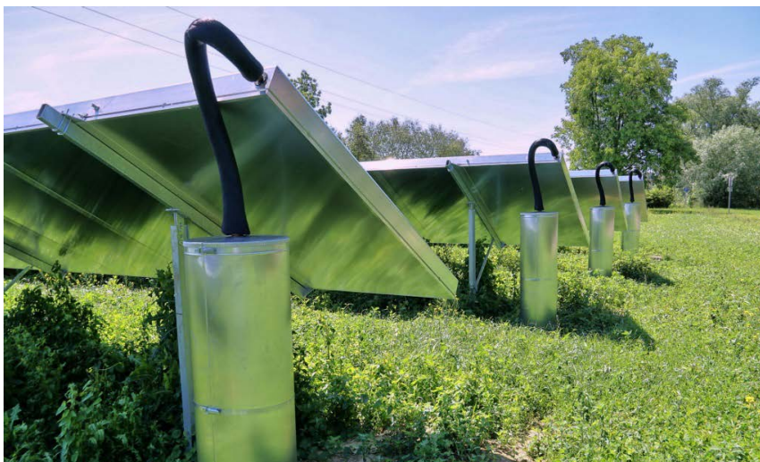
Abbildung 5: Schutz der Verbindungsleitungen im Kollektorfeld der Solarwärme-Freiflächenanlage St. Ruprecht, Stmk.
