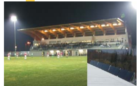
Fußballstadion in Gleisdorf, Steiermark mit einer 60 m 2 großen Solaranlage (kleines Bild) auf dem Stadiondach.
