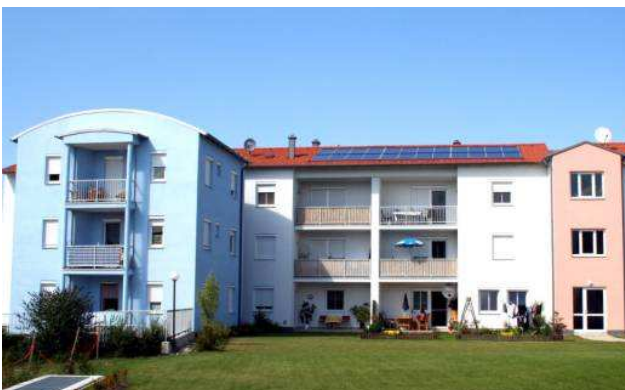
72 m 2 Kollektorfläche am 21 Wohnungen umfassenden Wohnprojekt in der Arbeitergasse, Schattendorf.
