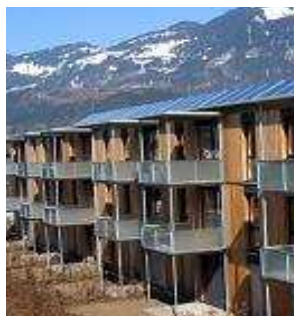
Solarkollektoren zur Warmwasserbereitung und Heizungsunterstützung in Niedrigenergie- und Passivhausprojekten der Vorarlberger VOGEWOSI.
