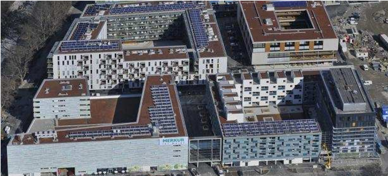
2008 wurde das Tivoli-Areal in Innsbruck mit ca. 1.200 m 2 Kollektorfläche eröffnet. Das Tivoli-Gelände besteht aus 472 Wohnungen, 126 Zimmer in einem Seniorenwohn- und Pflegeheim sowie einem Einkaufsareal.
