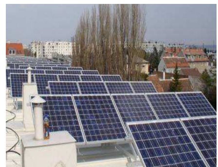
100 m 2 Kollektorfläche zur Warmwasserbereitung und Heizungsunterstützung sowie 93 m 2 Photovoltaikpaneele als integraler Bestandteil des Gebäudekonzeptes in der Wiener Schellenseegasse (Bildquelle: Büro Reinberg).
