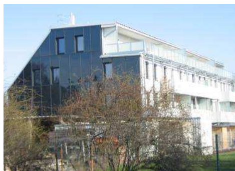
100 m 2 Kollektorfläche zur Warmwasserbereitung und Heizungsunterstützung sowie 93 m 2 Photovoltaikpaneele als integraler Bestandteil des Gebäudekonzeptes in der Wiener Schellenseegasse (Bildquelle: Büro Reinberg).
