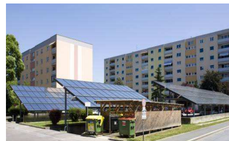
In der Grottenhofstraße in Graz werden die Sonnenkollektoren als Überdachung der Autoabstellplätze genutzt.
