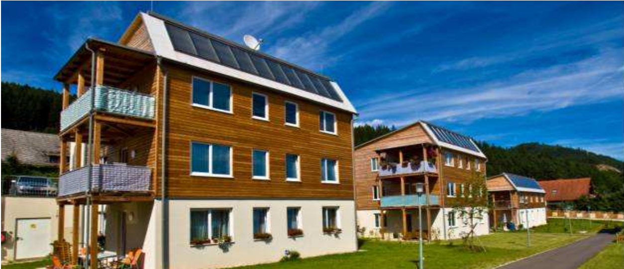
Solarwärmenutzung als Standard in den Wärmeversorgungskonzepten der Siedlungsgenossenschaft Ennstal, wie hier dargestellt in der Wohnanlage St. Peter Freienstein (21 Wohneinheiten, 72 m 2 Kollektorfläche)
