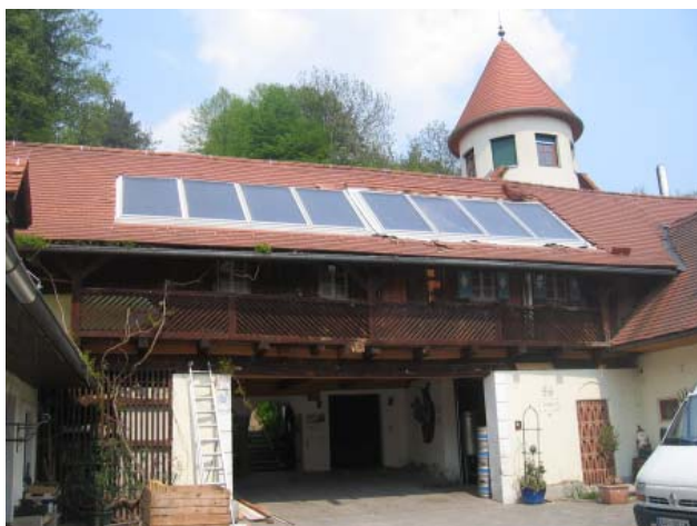
Die SONNENBRÄU Solaranlage
