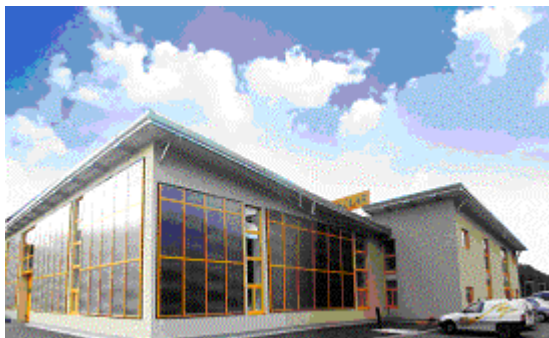
Solar beheizte Fertigungshalle des Solaranlagenherstellers SIKO Solartechnik, Jenbach, Österreich
